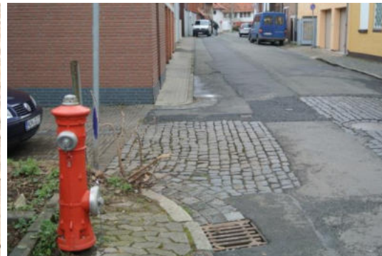
Gestaltungsdefizite: Untere Straße (nur nördlicher Teil) Quelle: eigene Aufnahme
