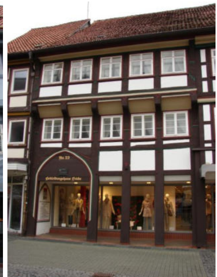
Anpassung an Gliederung der Fassade Quelle: eigene Aufnahme
