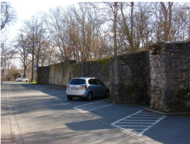
Unternutzung und in die Straße ragende Parkplätze in der Oberen Straße; Quelle: eigene Aufnahme
