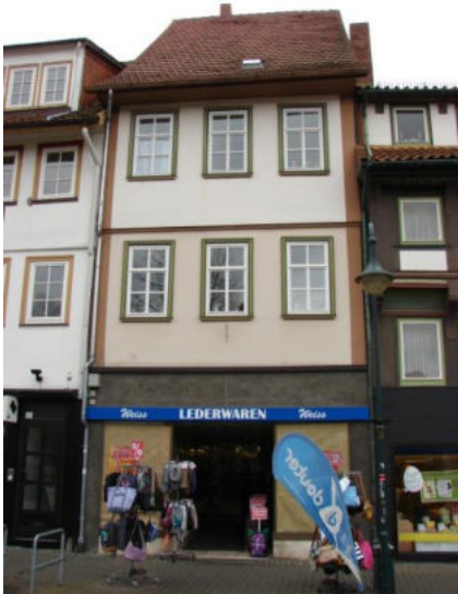
Modernisierungsbedarfe Am Münster, Quelle: eigene Aufnahme
