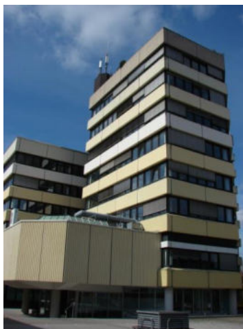
Ansicht Kreishaus Quelle: eigene Aufnahme
