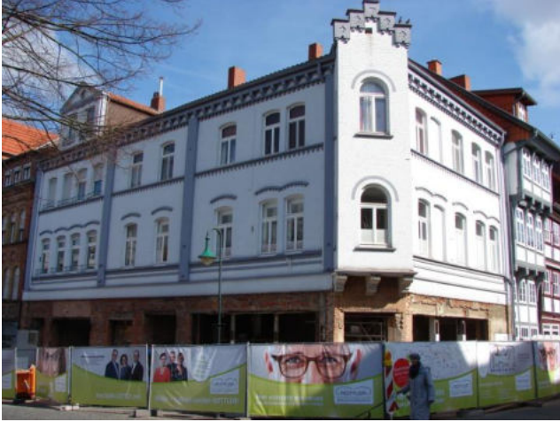
Laufende Modernisierung Markt 2 Quelle: eigene Aufnahme
