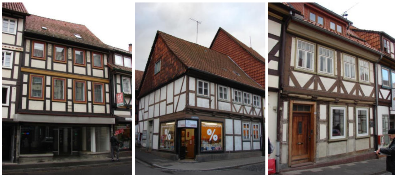
Gebäudebeispiele schlechter Zustand (Am Münster, Wierterstraße, Kurze Straße) Quelle: eigene Aufnahmen
