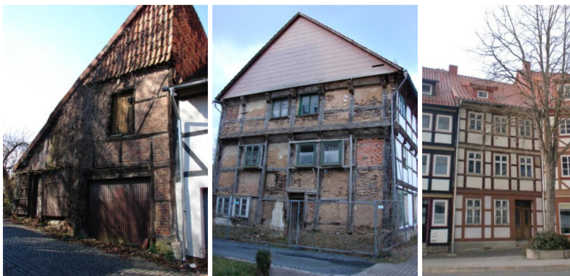
Gebäudebeispiele sehr schlechter Zustand (Obere Straße, Kirchplatz, Hinter der Kapelle) Quelle: eigene Aufnahmen
