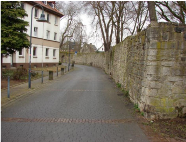
Erlebbare Stadtmauer am Alten Friedhof (Fußweg) Quelle: eigene Aufnahme
