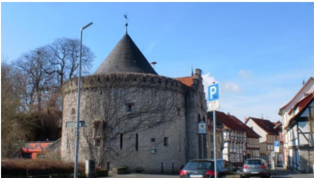
Stadteingang Schaupenstiel mit ehemaliger Brauerei Quelle: eigene Aufnahme
