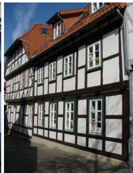
Fachwerk in der Braunschweiger Gasse; Quelle: eigene Aufnahme
