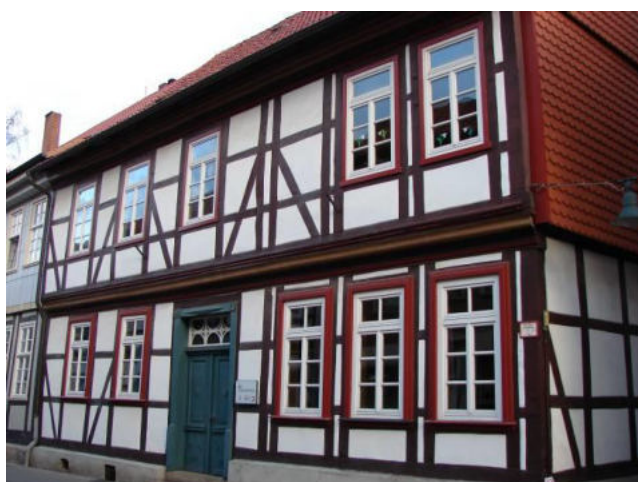
Kita in der Hagenstraße Quelle: eigene Aufnahmen
