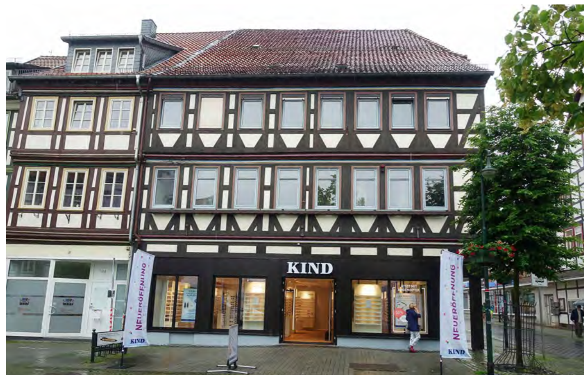
Abbildung 13: Saniertes Wohn- und Geschäftshaus Breite Straße 12
