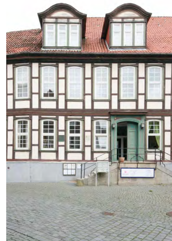
Abbildung 30: Verbändehaus „Entenmarkt 3-4“ Quelle: Bestandserhebung Hoegg
